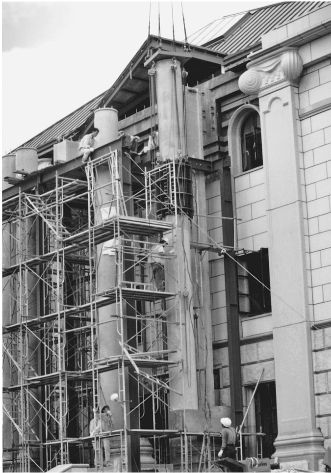
建設中の植野記念美術館（1994年）
